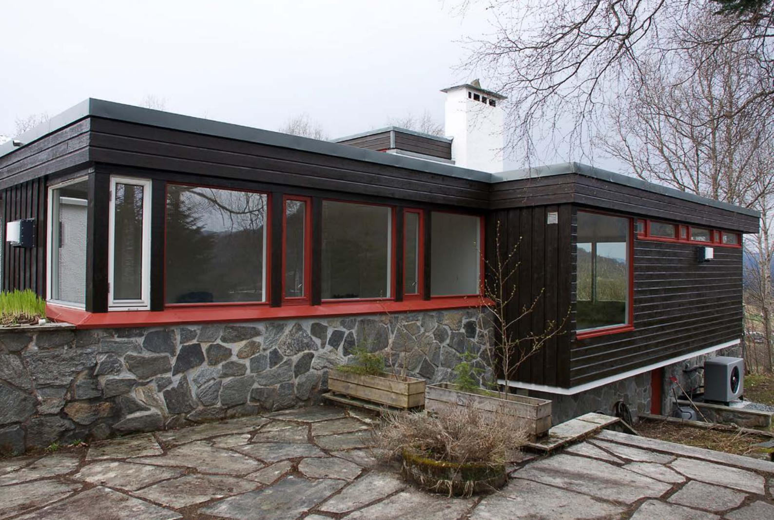
Nordfasaden sett mot vest
