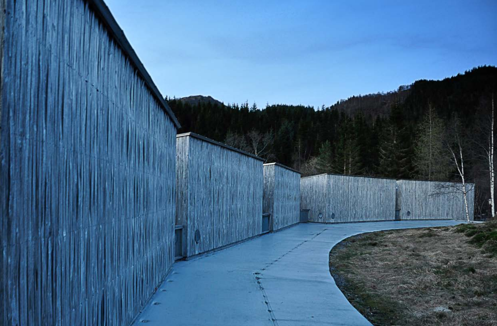
Ateliera, bakveggen, mot sør
